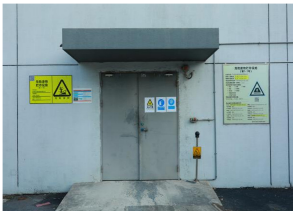
危废贮存仓库
